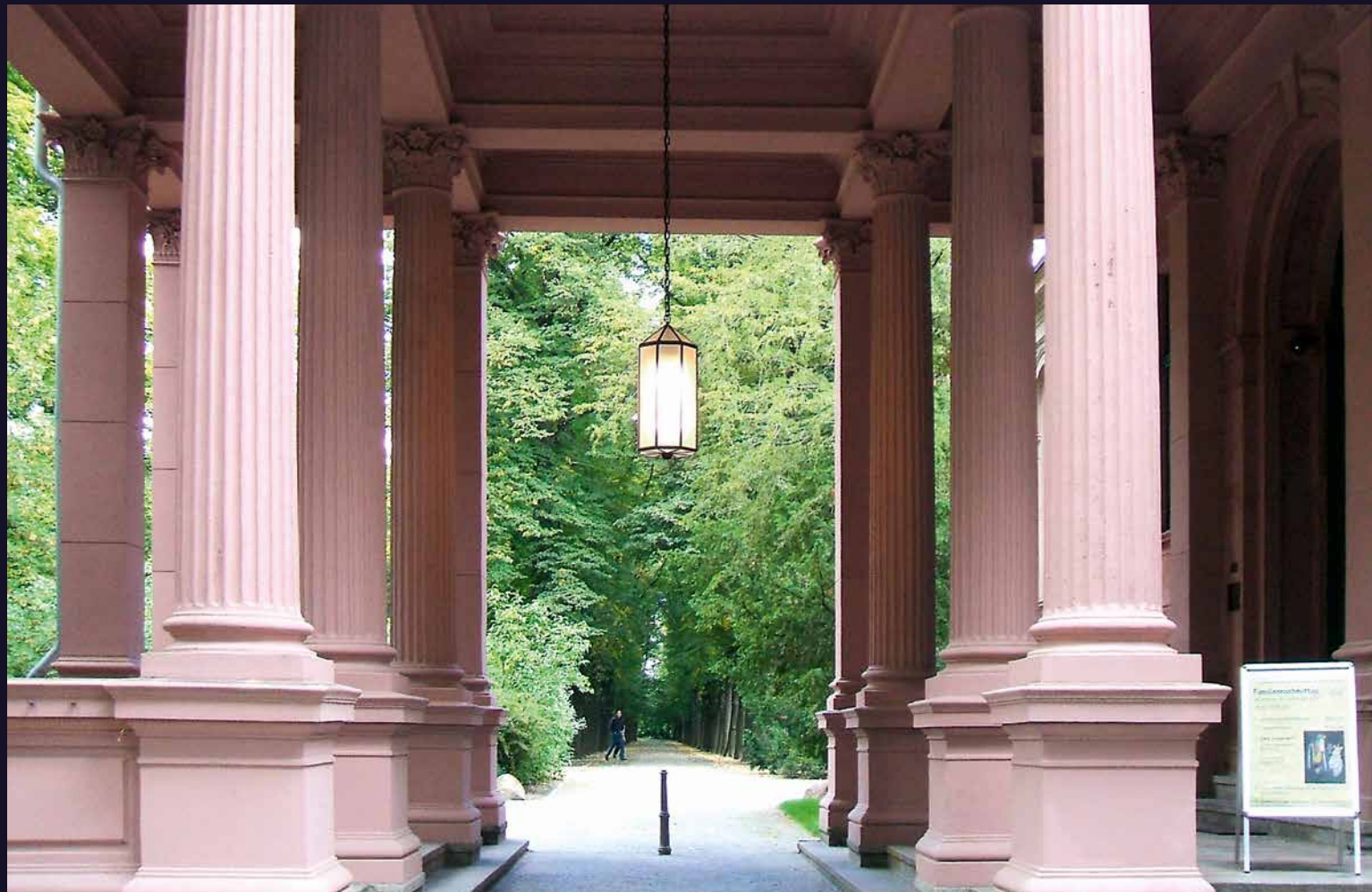
Oben: Rekonstruktion historischer Aufsatzleuchten, Neues Palais Potsdam | Unten: Rekonstruktion einer Pendelleuchte, Schloss Alt-Biesdorf, Berlin
